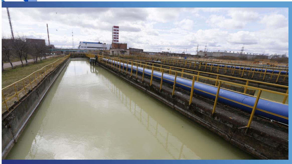
С 1995 г. ведётся строительство третьей очереди очистных сооружений сточных вод, рассчитанной на приём и очистку 33 тыс. м<sup>3</sup>/сут.
